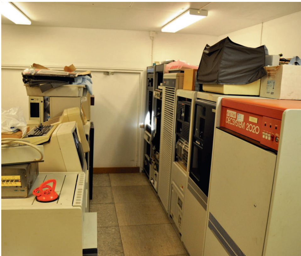
Pontus har byggt en datorhall i sitt garage. På den bortre väggen kan man se den gamla garageporten.
